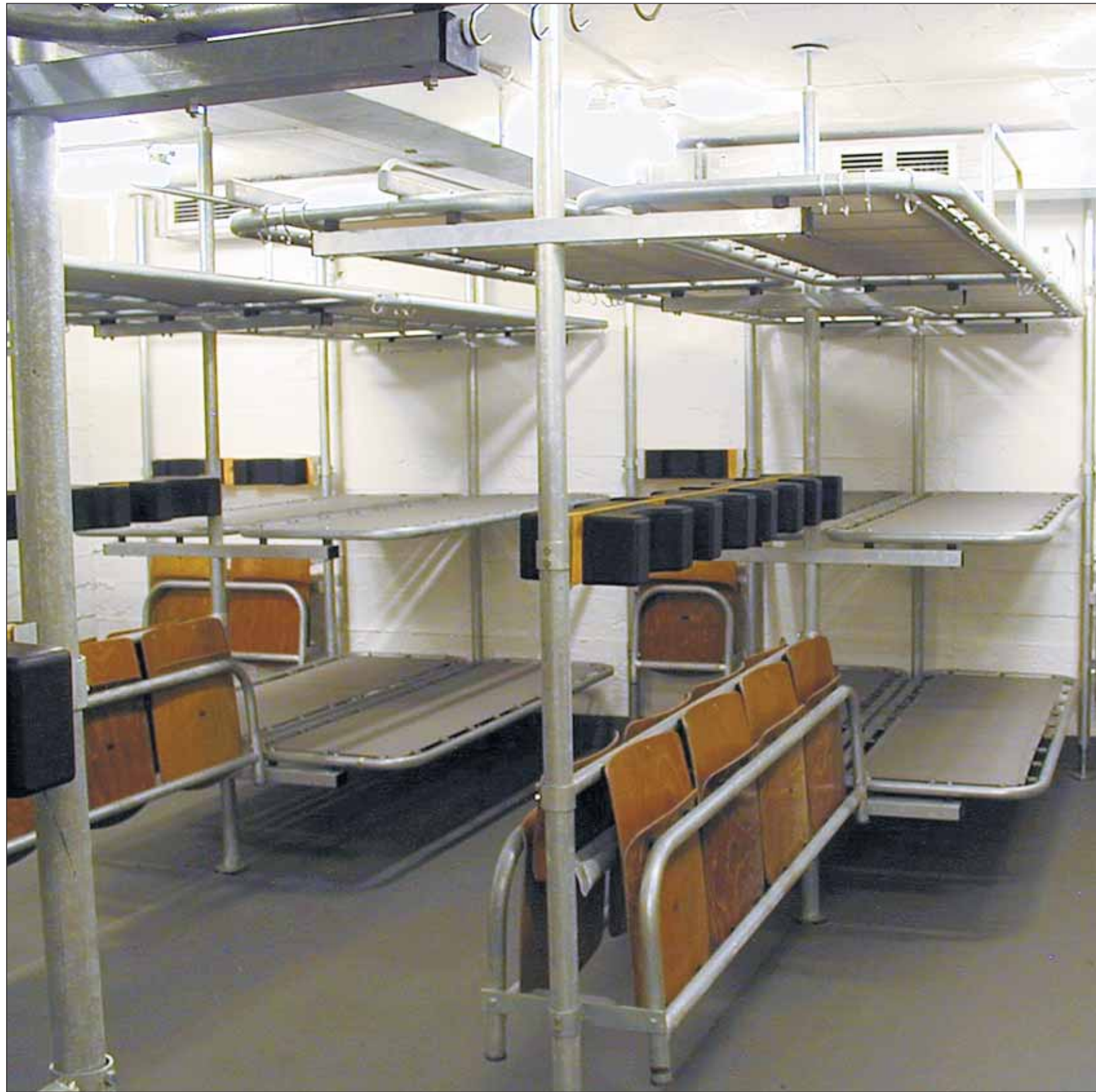
Eine unheimliche Atmosphäre herrscht in den Schlaf-Räumen. Schwarze Schaumstoffvorrichtungen über den Klappsitzen sollen Erschütterungen der Köpfe verhindern. Fotos: Förderverein Historischer Zivil- und Bevölkerungsschutz e.V.
